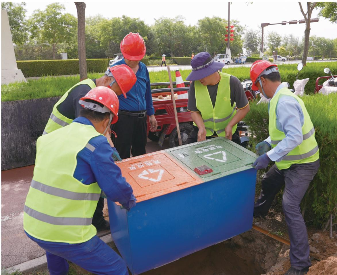
高新区安装地理式垃圾箱，成功化解垃圾外漏、污水外溢难题
